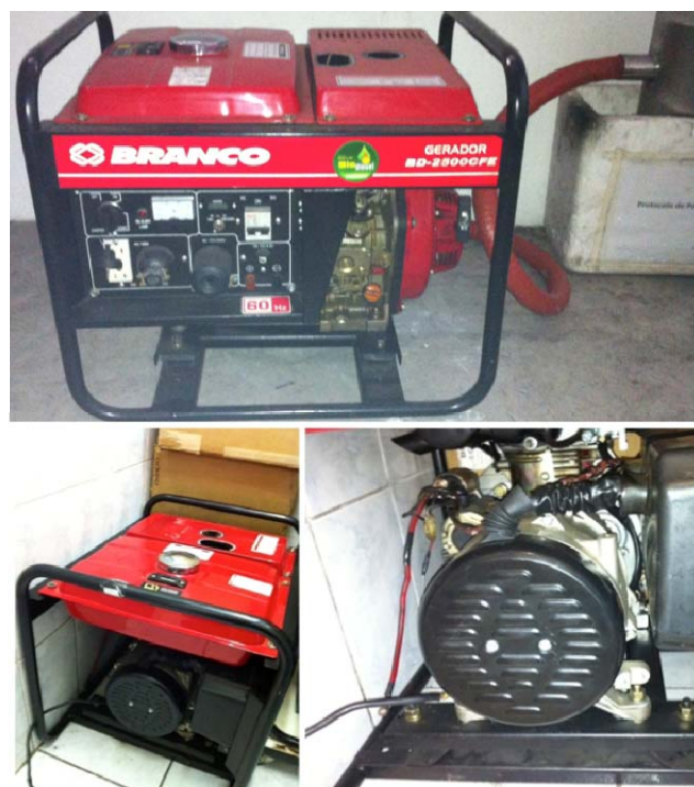
Figura 3 - Moto-gerador elétrico estacionário Toyama movido à diesel
