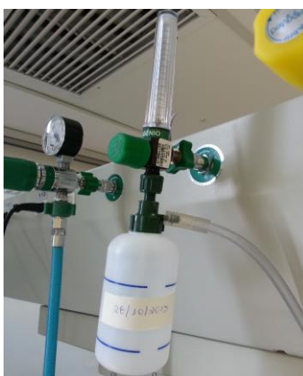
Figura 14: Conexão extensão PVC
