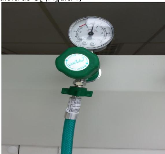
Figura 1 Válvula redutora de O<sub>2</sub>
