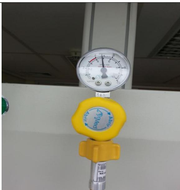
Figura 2 Válvula redutora de ar comprimido
